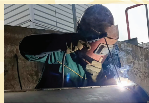
河北正华生产处维修工 徐艳丽
